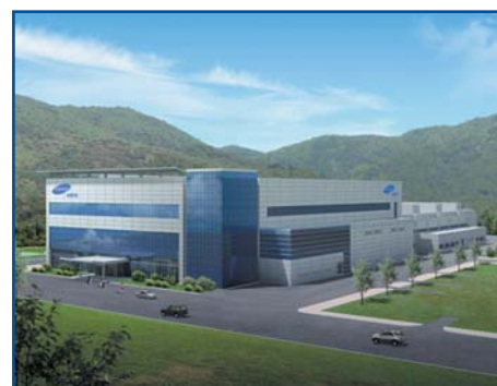
Рис. 5. Завод Samsung Techwin в Соннам-Сити, Южная Корея, на котором производится автоматы SM-321
