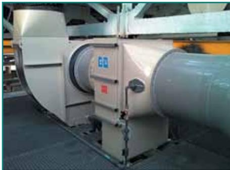
**Рис. 10.** Вентилятор с каплеотделителем
