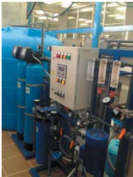
Рис. 13. Обратноосмотическая установка
